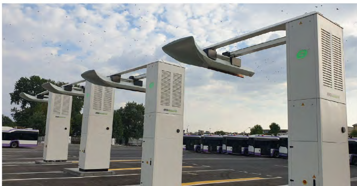
Figura 4.19. Infrastructură pentru încărcare rapidă, tip pantograph.
